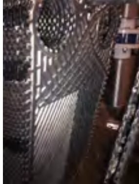
Filtrováno pomocí automatického filtru BOLLFILTER Typ 6.19 Úroveň filtrace 150 µm
