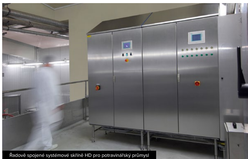
Řadově spojené systémové skříně HD pro potravinářský průmysl
