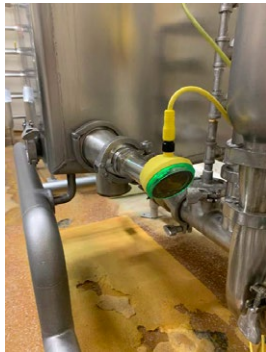
Měření tlaku v nádrži VEGABAR 38
