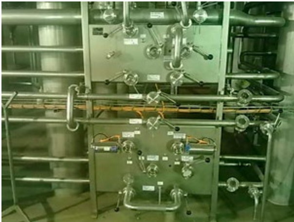
Rozvodné desky potrubí
